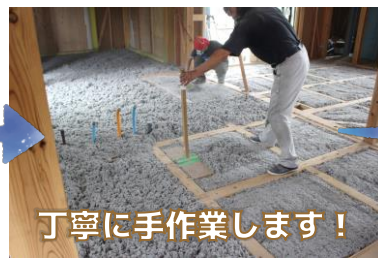
床下・壁・天井に施工
